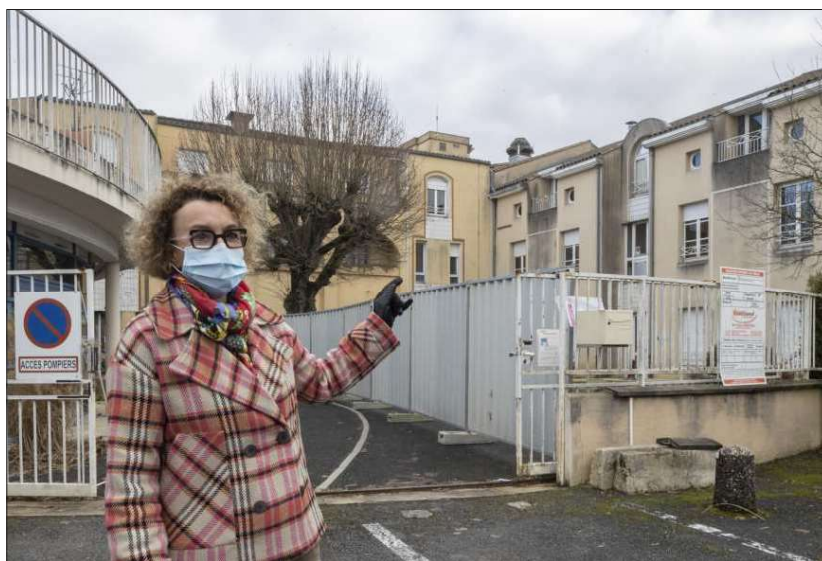
Caroll Freyche, directrice déléguée de l'Ehpad Habrioux, n'a pas renouvelé tous les départs pour garder neuf lits disponibles le temps des travaux.
