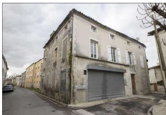
L'ancienne cave d'Aigre va être démolie pour accueillir le futur parvis d'accueil de l'Ehpad Habrioux.
