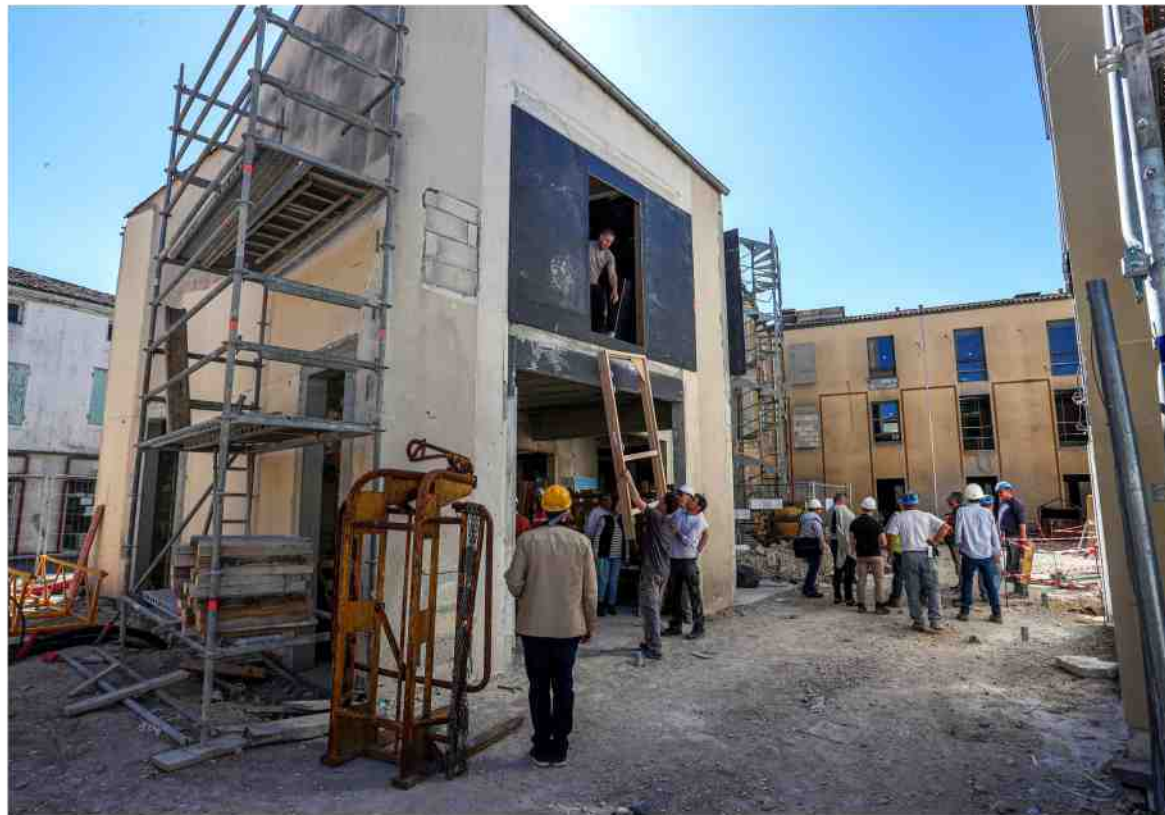
La troisième et dernière phase des travaux de l'Ehpad Habrioux s'attaque notamment à la partie accueil, lieux de vie et bureaux administratifs. Julie Desbois
